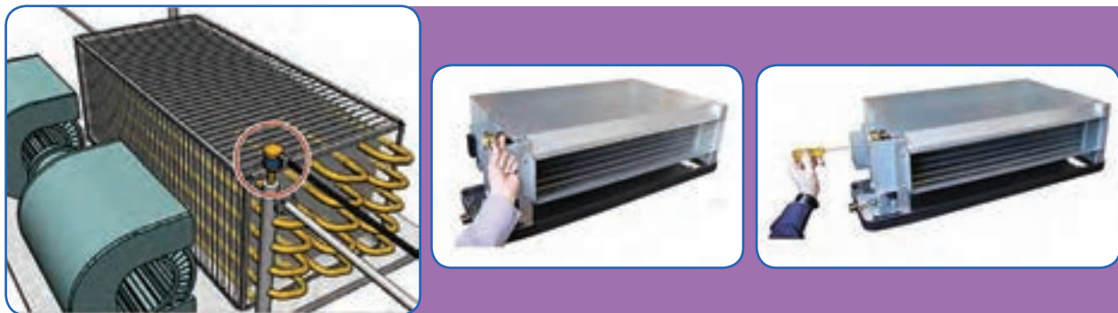
شکل ۲- هواگیری فن کویل
