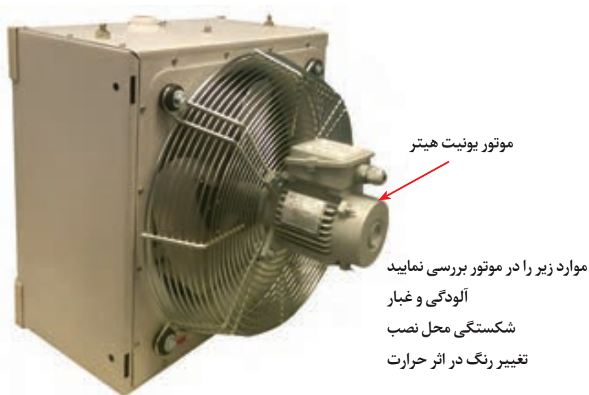
شکل ۱۸- کنترل ظاهری موتور یونیت هیتر
