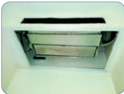
شکل ۱۳- نمونه دریچه دسترسی و برگشت هوا
