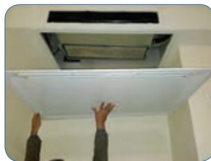
شکل ۱۳- نمونه دریچه دسترسی و برگشت هوا
